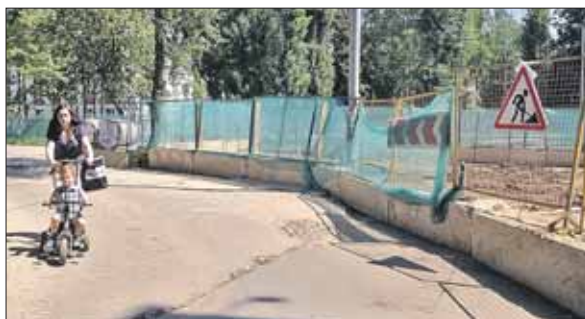
После замены трубы водопровода и прокладки дренажной трубы место раскопа заасфальтируют и благоустроят
